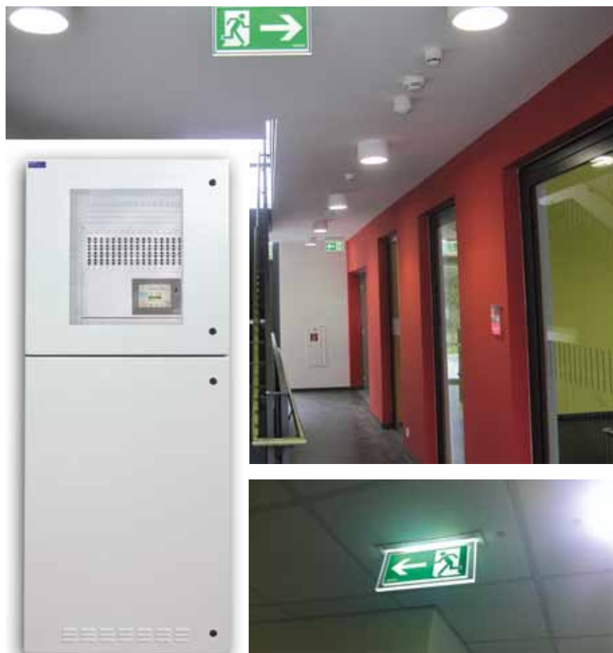
Fot. 3. W systemach oświetlenia awaryjnego stosuje się systemy baterii centralnej o dużej pojemności. Z lewej strony widoczna bateria centralna CPS220/64 firmy Inotec. Gdy w przypadku awarii prądu bateria ta musi zapewnić zasilanie awaryjne, bezpieczniki powinny być w stanie wyłączyć duże prądy zwarciove (DC)
